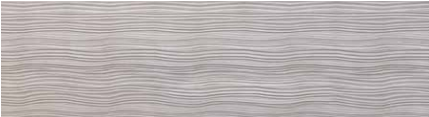
Socle en béton matricé
